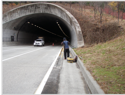
단면측량 전경 ①
